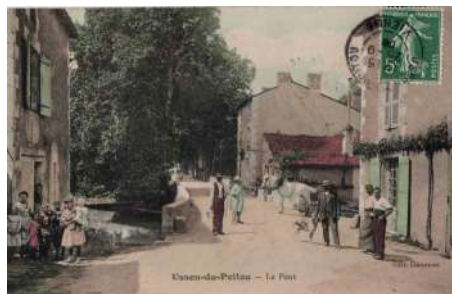
Le pont et les bains-douches, appentis couvert de tuiles rouges Carte postale ancienne - Coll. privée
